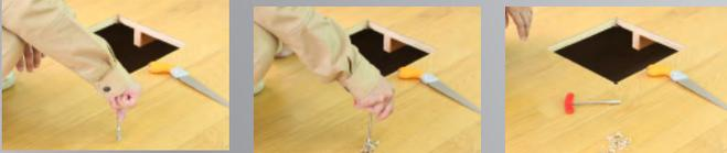
7. 右図④の穴より矢印の方向に鋸で切り進み、開口部より辺を延長する。
