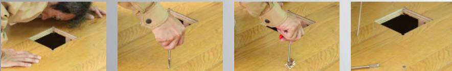
5. 右図③の穴より矢印の方向に鋸で切り進み、開口部の辺を延長し、開口部に頭を入れ生存者の目視及び声掛けの確認を行う。
